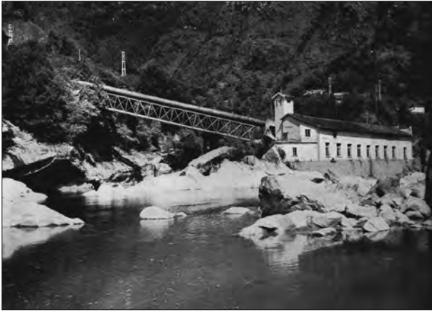
Une des premières centrales électriques du Tessin, construite sur la Maggia à Pontebrolla en 1904; elle était destinée surtout à produire de l'électricité pour l'éclairage de Locarno et des localités avoisinantes. Source: Società Elettrica Sopracenerina 1904-1954 , Locarno [1954], p. 83.
